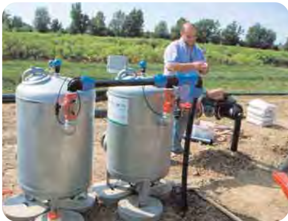
Un operatore sta effettuando dei lavori di manutenzione sulle componenti di alcuni impianti irrigui.
