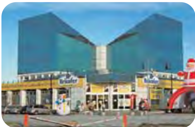
Una delle realizzazioni recenti del Gruppo Cofra: il Bricofefer di Rimini.
