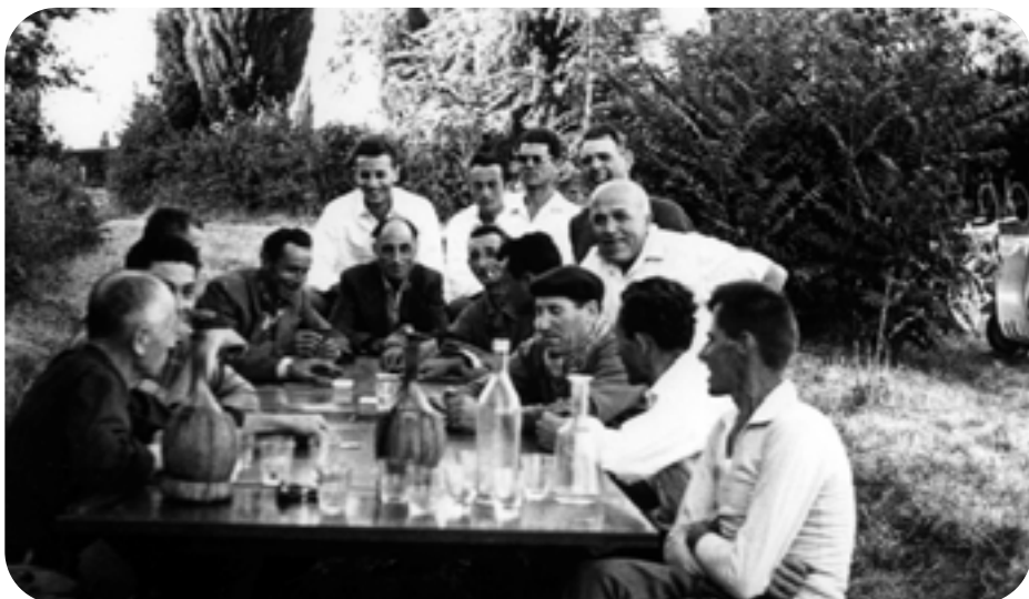
Una delle foto 'storiche' tratta dal libro 'Immagini di cooperazione'. Rappresenta una "bandèga", la merenda dei lavoratori insieme al proprietario, in un cantiere della CMCF durante gli anni Cinquanta.
